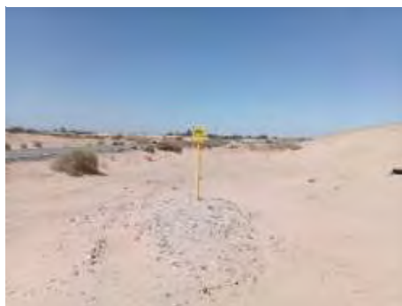
Figura 32: Señalización de gasoducto existente.
