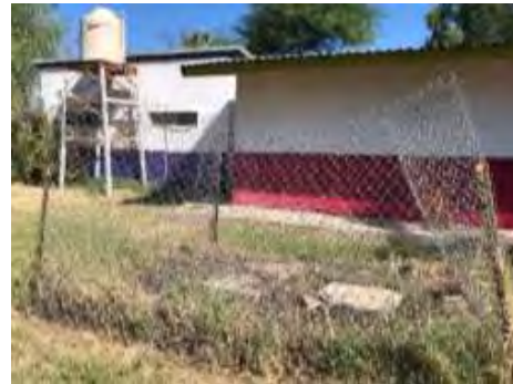
Figura 61: Fosa séptica en instalación escolar del Ejido Guanajuato.
