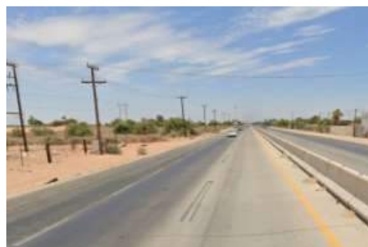
Figura 109 :Vista carretera Sonoita-Mexicali.
