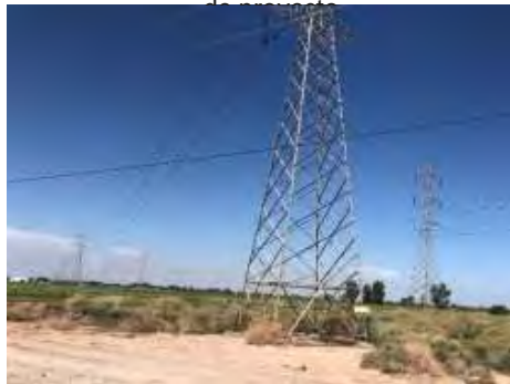
Figura 68 : Doble línea de alta tensión en Cerro Prieto No. 4 cruce con el gasoducto
